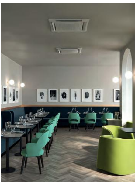
SKYSAFE en falso techo
